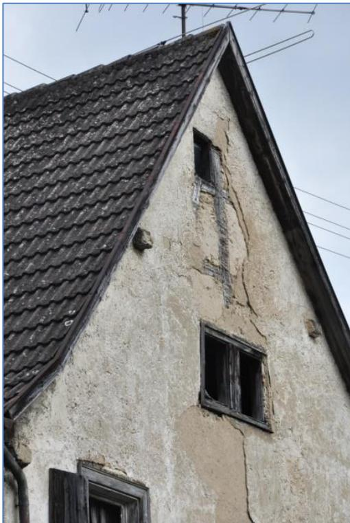
Deutlicher wird dies bei der Rückansicht (Südseite) links: hier liegt die Firstsäule teilweise frei. Das „Behnefensterle“ liegt deutlich außermittig NEBEN der Firstsäule. Und im Geschoss darunter geht die Firstsäule sogar durch das Fenster durch und wird zum Mittelpfosten.
