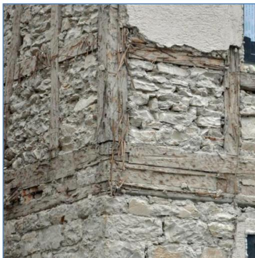
Die zweite Methode war das Ausmauern mit Bruchsteinen. Hier in Ehingen nahm man dazu überwiegend Kalkstein. Dafür konnte Material von Abbruchhäusern wiederverwertet werden, auch zerbrochene Ziegel und Dachplatten wurden verwendet. Erst in späterer Zeit wurden auch neue Ziegel verwendet. Ein teures Material, dessen Verarbeitung zeitaufwendig war, da am Rand der Ausfachung die Ziegel örtlich eingepasst werden mussten. Anschließend musste auch dieser Wandaufbau verputzt werden.
