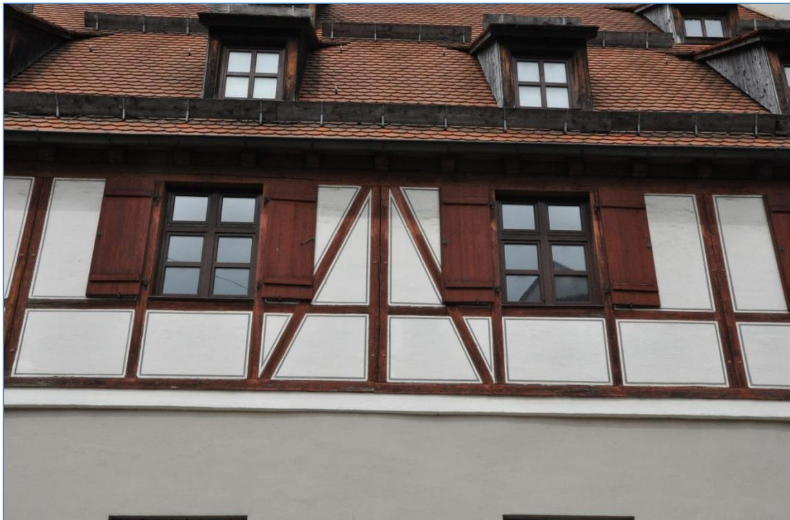
Der Zwischenbau Zwischen Museum und Spitalkirche ist ein Neubau aus den 1980er Jahren. Hier wurde das sog. Amtshaus, ein Fachwerkbau von 1470, abgebrochen. Das jetzige Fachwerk ist ein reines Micky-Maus-Zierfachwerk, auf dem Massivmauerwerk aufgesetzt und nicht tragend. Es entspricht auch keineswegs traditionellen Fachwerk-Regeln.
