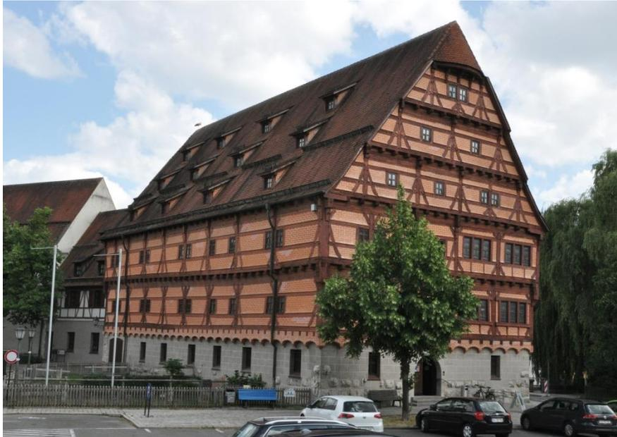
Die Ostseite des Museums Gut erkennbar (trotz der Sanierungsarbeiten) ist die Senkung des Fachwerks über dem Schmiededurchfluss. (Bei genauem Hinsehen erkennt man auf dem abgewandten Giebel einen Storch auf der Suche nach einer Nistmöglichkeit.)
