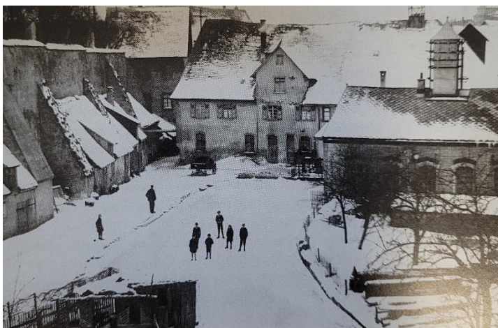
Die Heckenmühle im Jahrhundertwinter 1928/1929: Die Schmiech ist zu einer Eisfläche erstarrt, fallenstock und Rechen am Einlauf vereist, die Mühle steht still. Das >>Schalthaus<< rechts vorn – um die Jahrhundertwende errichtet – steht als Zeichen des technischen Umbruchs zur Energiegewinnung in der Heckenmühle. Die kleine Hütte im Vordergrund ist das Badehäuschen vom Alt-Heckenmüller Wendelin Maunz, der als Anhänger von Sebastian Kneipp dort seine Badegänge im frischen Schmiechwasser absolvierte.
