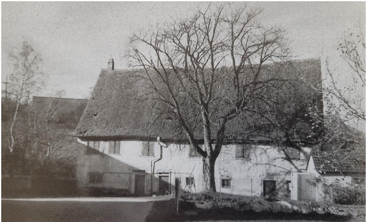
Der Mühlenbetrieb in der Muckenmühle wurde nach dem Ersten Weltkrieg eingestellt, die Turbinenanlage wegen geringer Rentabilität etwa 1960 ausgebaut.
